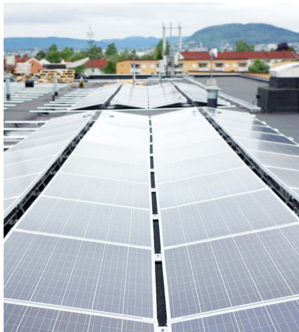
180 aurinkopaneelia asennettiin KONEen Osloon-pääkonttorin passiivienergiataloon toukokuussa 2016. Ne peittävät kolmasosan katon pinta-alasta.
